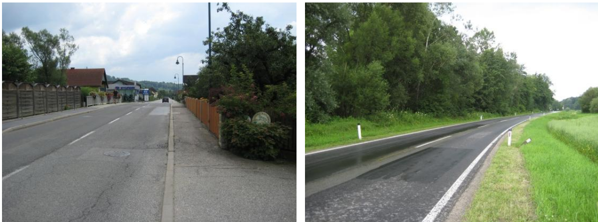
Abbildungen 21: Murbergstraße, Ferbersbachbrücke, Ortsgebiet von Fernitz (3a) / Blickrichtung Enzelsdorf; links der Mühlkanal (3b)
