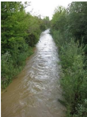
Blickrichtung bachabwärts, die harte Verbauung unter Gehölz versteckt (12f)
